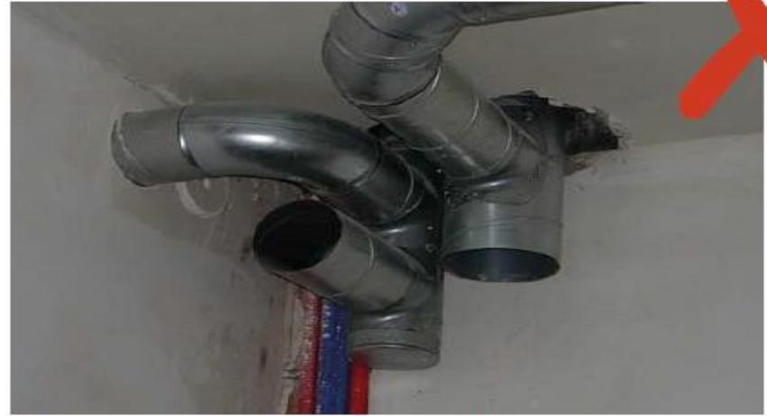
**Fig. 44** Espace réduit rendant impossible une étanchéification correcte des percements.
