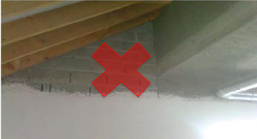
**Fig. 51** Surface de blocs maçonnés non enduite au-dessus du niveau d'un plafond suspendu : source de fuites.
