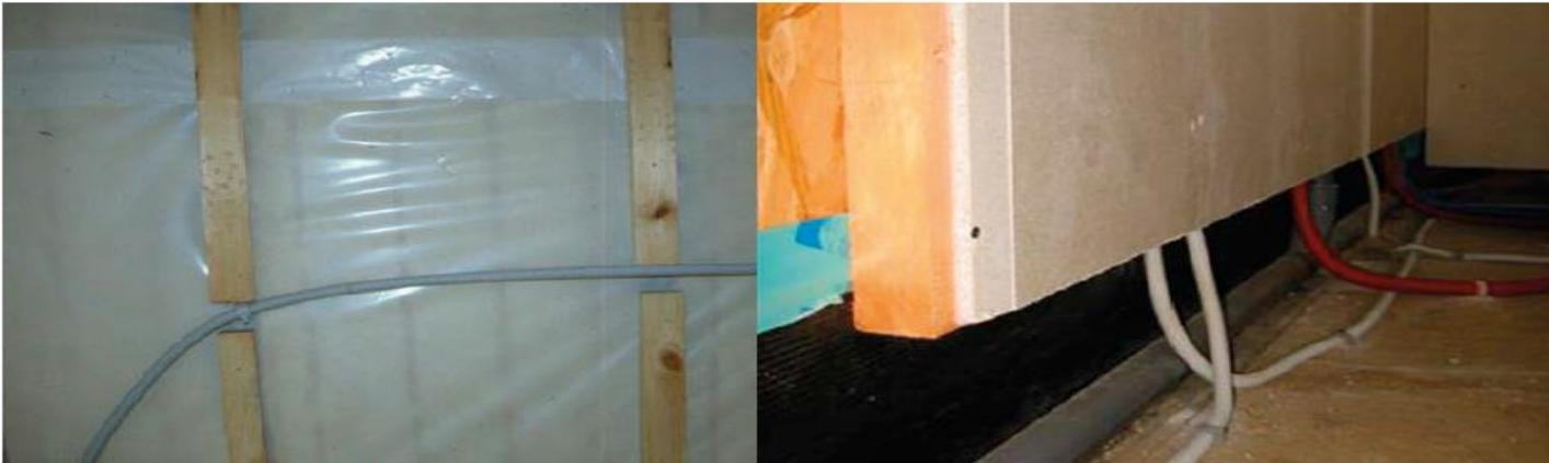
Fig. 36 Exemples de contre-cloisons permettant le passage de câbles et de conduites électriques sans perçage du pare-air.
