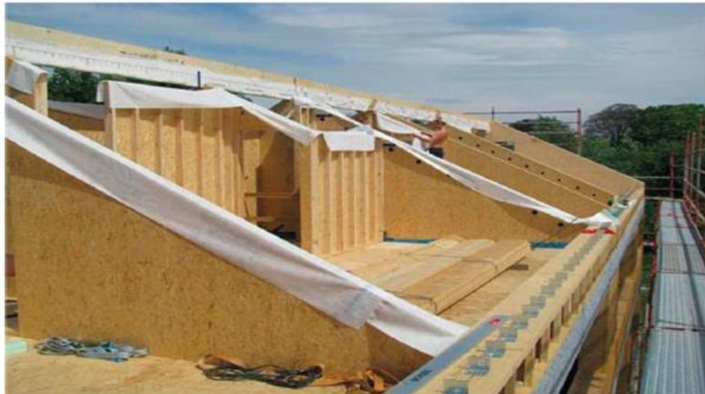
Fig. 92 Membranes en attente permettant d'assurer la continuité de l'étanchéité à l'air des versants de toiture.
