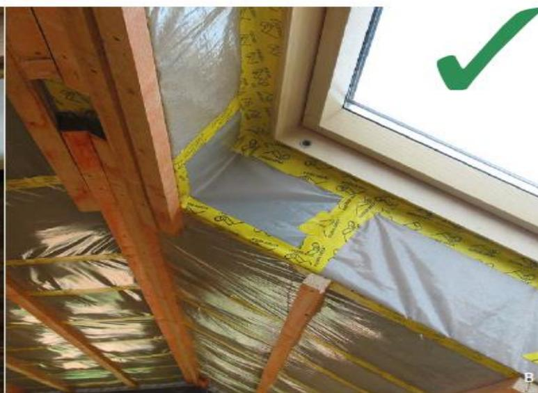
Fig. 95 Etanchéité à l'air autour d'une fenêtre de toiture : exemple de réalisation inacceptable (à gauche) et de bonne réalisation (à droite).
