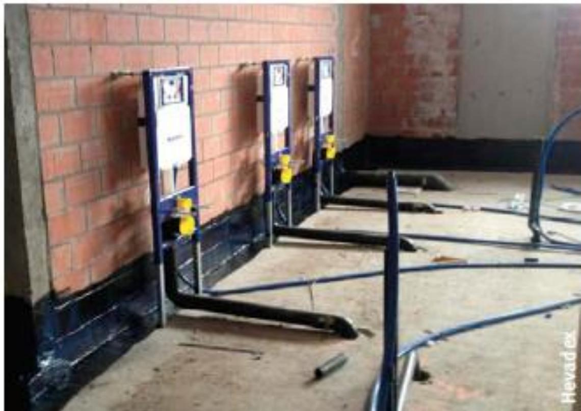
Fig. 76 Etanchéité à l'air liquide appliquée en pied de mur.
