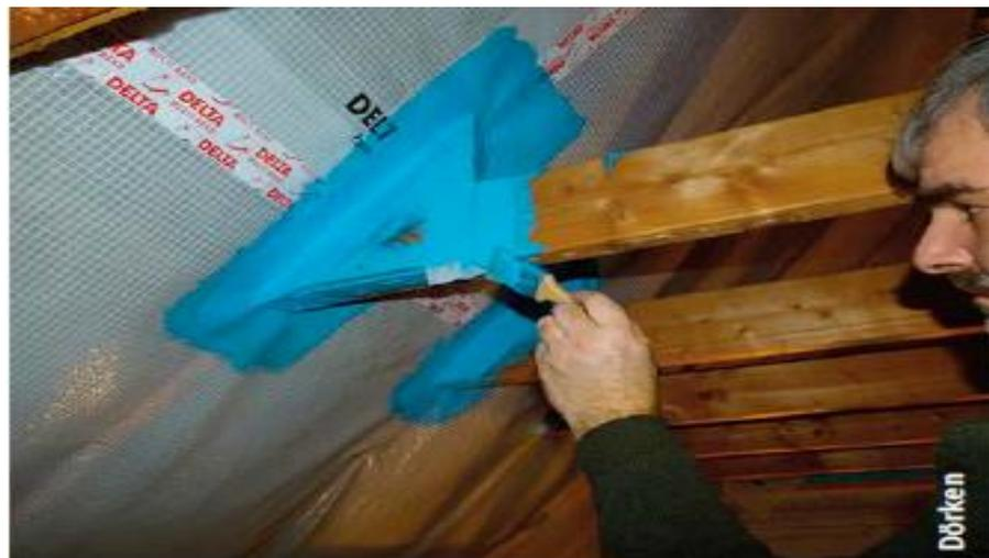
Fig. 70 Mise en œuvre d'une étanchéité à l'air liquide au droit de la traversée des membrures d'une charpente.
