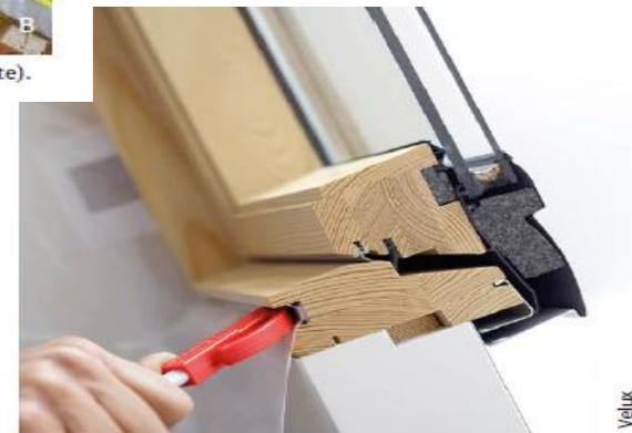
Fig. 97 Exemple de profilé de châssis facilitant la jonction entre un pare-air souple et une fenêtre de toit.
