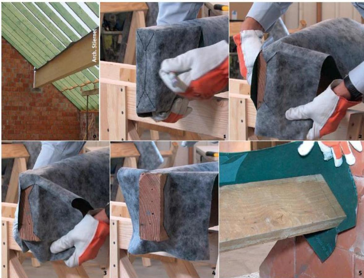
Fig. 87 Pose correcte des membranes en attente sur les pannes, mais risque de fuites d'air aux extrémités des pannes (o) et exemple de résolution à l'aide d'un manchon confectionné sur place (1-2-3-4-5).
