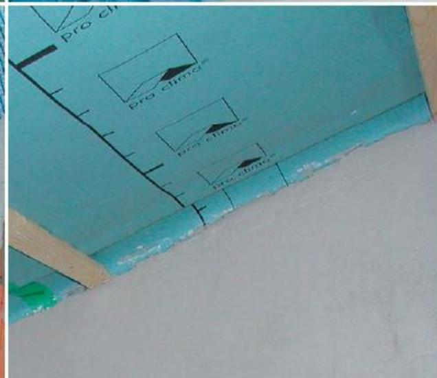
La jonction du pare-vapeur avec les parois adjacentes doit être réalisée avec un grand soin afin d'éviter toute fuite d'air au niveau de ce raccord.
