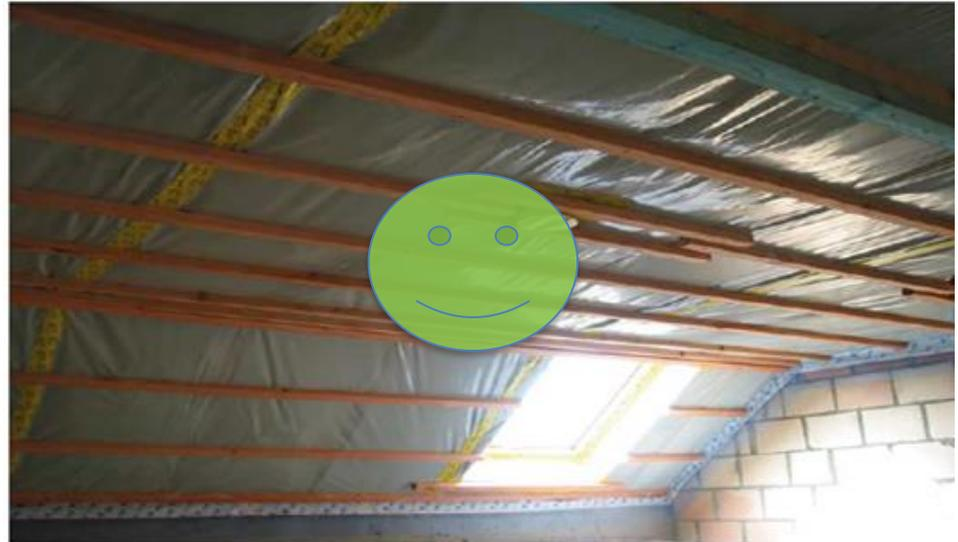
**Fig. 52** Jonctions entre lés réalisées avec des bandes adhésives pour assurer l'étanchéité à l'air d'une toiture à versants.
